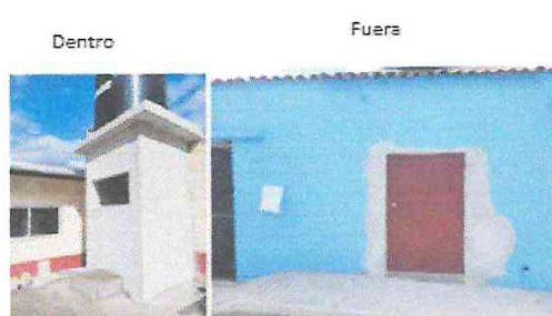
Foto 4: Remodelación para depósito de basura (sellado y tallado)
