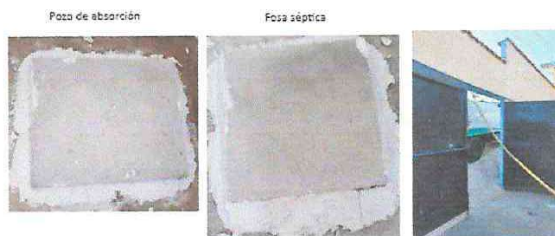
Foto 2: Mantenimiento de fosa séptica (Extracción de desechos orgánicos)
