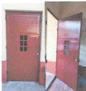
Foto 3: Instalación y suministros para puertas de metal, cocina, aulas y depósito para basura
