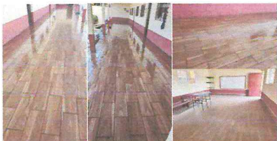
Foto1: Instalación y suministros de piso cerámico en 5 aulas, 2 corredores, dirección, y bodega
